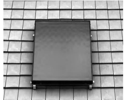
Nota: Para filas de más de dos colectores se deberán montar suplementos a partir del tercer colector. Por ejemplo, en una fila de 5 colectores se deberá montar un soporte para dos colectores y tres suplementos.
