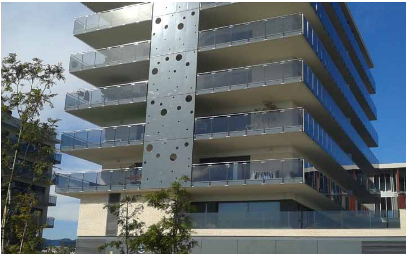
Edificio plurifamiliar, Barcelona, España
